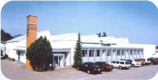
Production site in Meisterschwanden Site de production à Meisterschwanden
